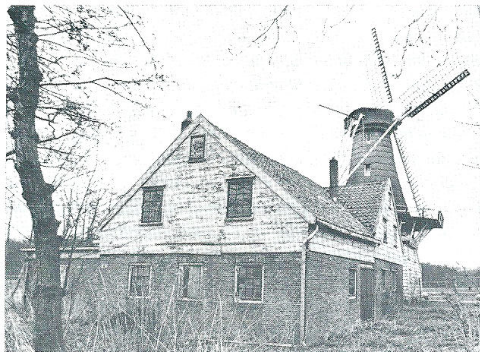
De vervallen carottenfabriek van de firma Hioolen aan de Kralingse Plas
